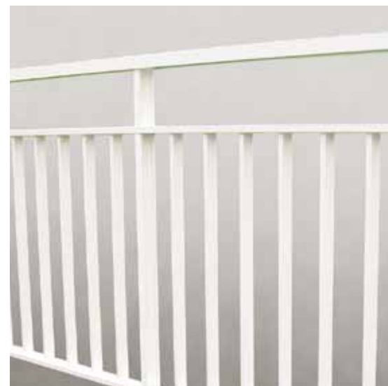
Rekkverk med vertikalspiler.
